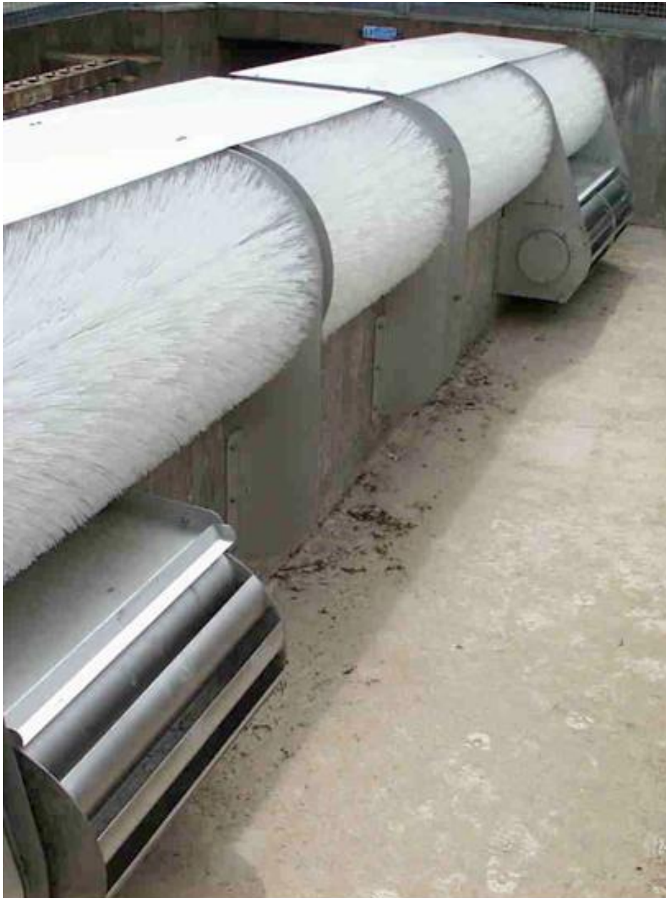
Fig. 5 - Esempio di Hydroclean dotato di due ruote idrauliche
